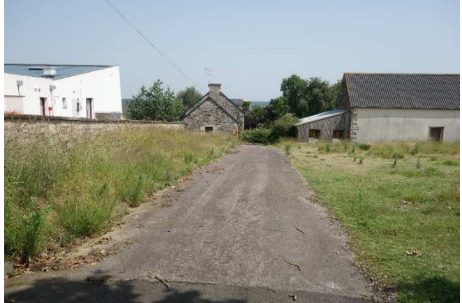
Accès nord (partie non requalifiée)
