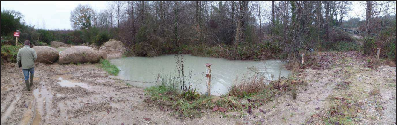
Photo 1. Bassin de décantation C1.
