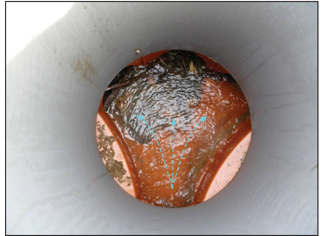
Photo 6. Exemple de répartiteur de débit à 3 sorties.
