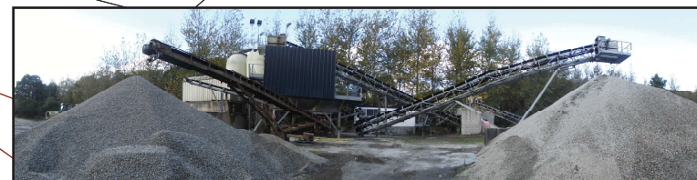
5 Stockage au sol des matériaux traités
