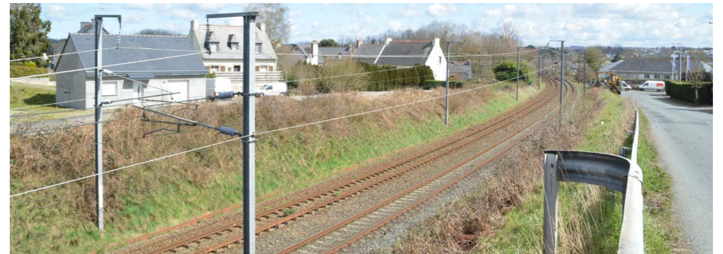
PHOTO 27 : PORTION FERROVIAIRE DE LA VOIE FERRÉE SAINT-BRIEUC / BREST DANS LA VILLE DE GUINGAMP (© SARL LAURENT COÛASNON)
