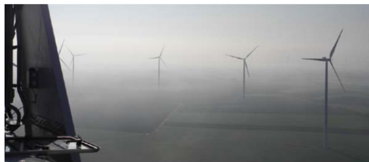
Figure 6 : Parc éolien de Voyennes (source : Clos Neuf Energies, 2017)
