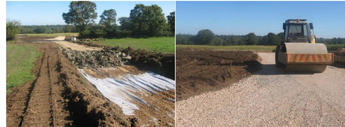
Figure 49 : Construction et terrassement des voies d'accès (source : Clos Neuf Energies, 2017)
