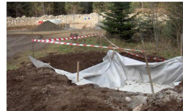
Figure 47 : Excavation pour déchet à proximité d'une plateforme temporaire (source : Clos Neuf Energies, 2017)
