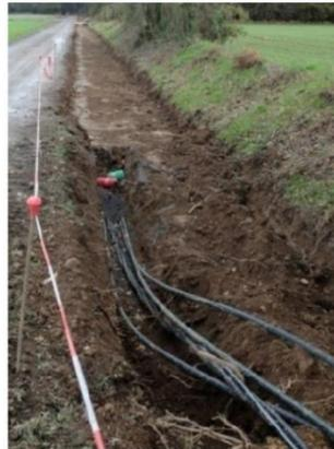
Figure 43 : Enfouissement des câbles (source : Clos Neuf Energies, 2017)
