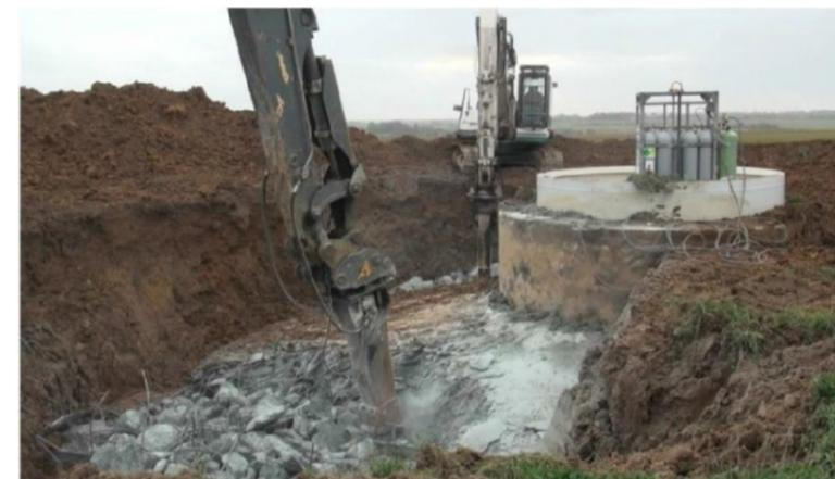
Figure 50 : Démantèlement d'un parc éolien à Criel-sur-Mer (source : Valorem, 2017)
