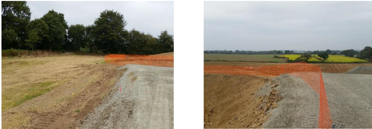
Figure 94 : Exemples de filet de chantier permettant de délimiter des emprises au sol (source : Althis, 2018)
