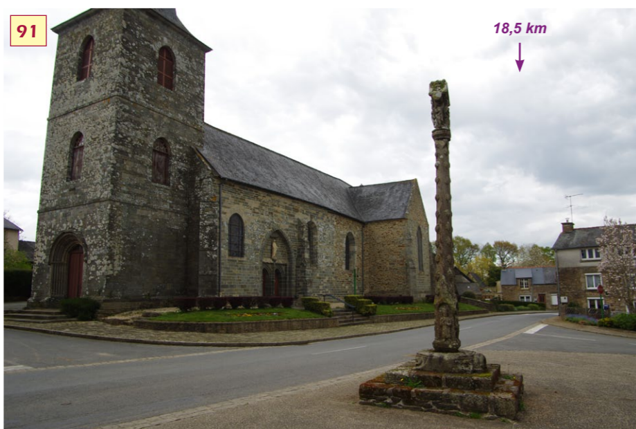
Dans le bourg de la Ferrière, la vue est fermée par le bâti qui borde l'église et la croix du 17 e .
