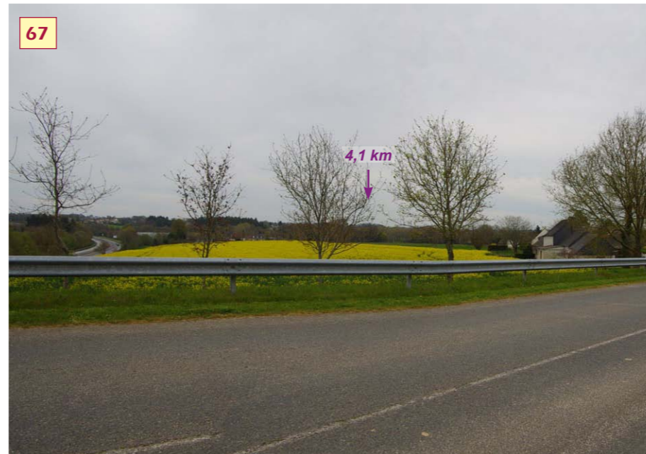
À la sortie sud de Merdrignac, après avoir traversé la N 164, la D 26 bénéficie de la hauteur créée pour les besoins du pont : on observe une perception en direction du secteur du projet filtrée par les arbres d'alignement au premier plan, et tronquée par les haies plus lointaines.
