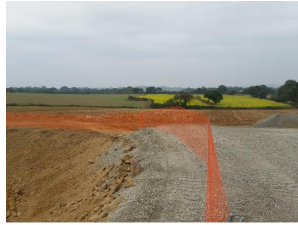
Photo 25 – Autre exemple filet de chantier.
