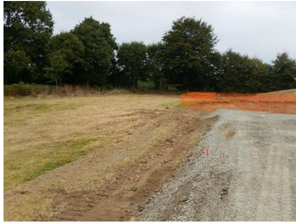
Photo 24 – Exemple de filet de chantier permettant de délimiter des emprises au sol.
