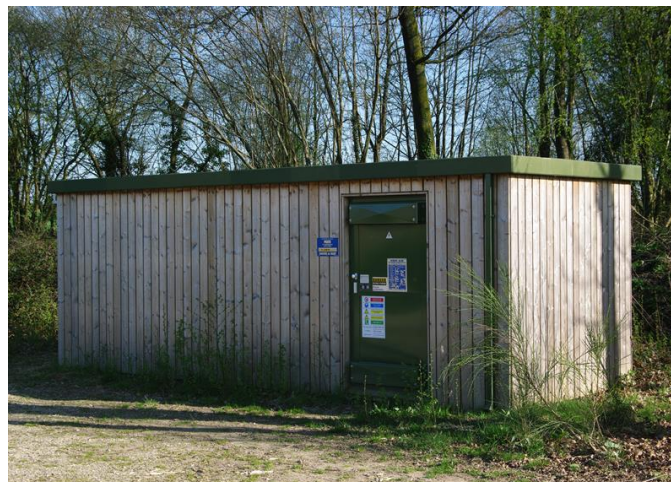
Photo 23 - Type de poste électrique
