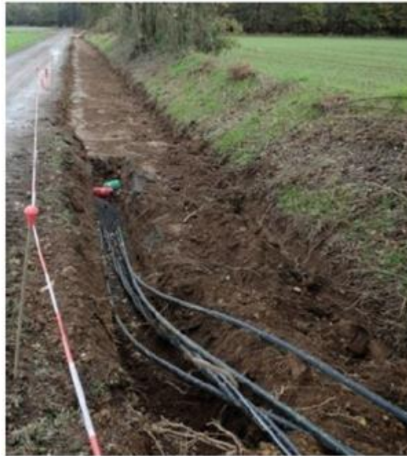
Photo 22 - Enfouissement des câbles
