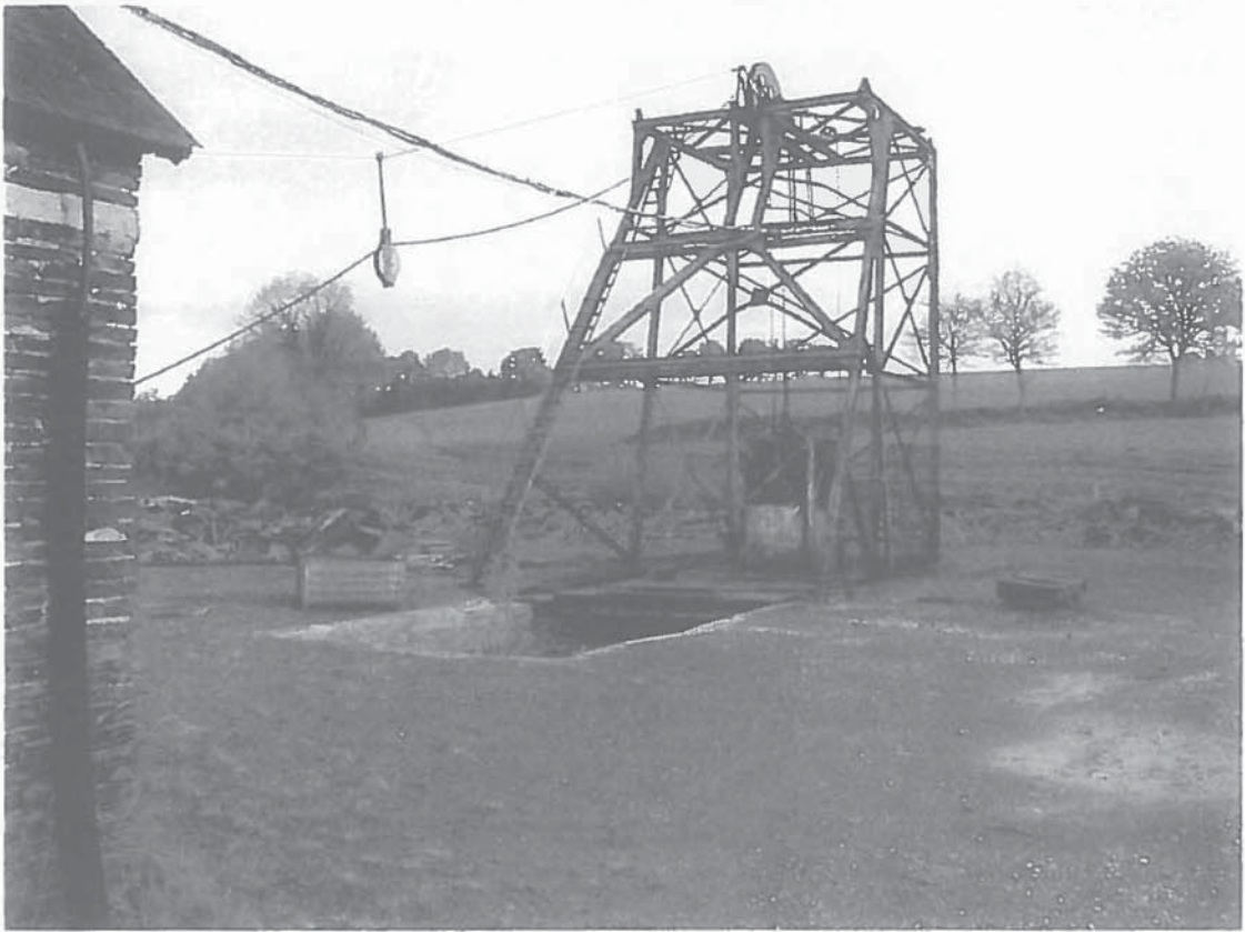
Photo n° 3 : Puits de « la Prairie », vue du chevalement et de la nacelle permettant la descente au fond (Vue prise le 25 avril 2003)
