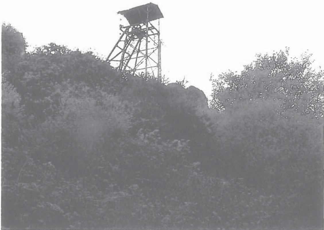
Photo n° 8 : Puits « du Milieu », autre vue en contrebas du chevalement (Vue prise le 25 avril 2003)
