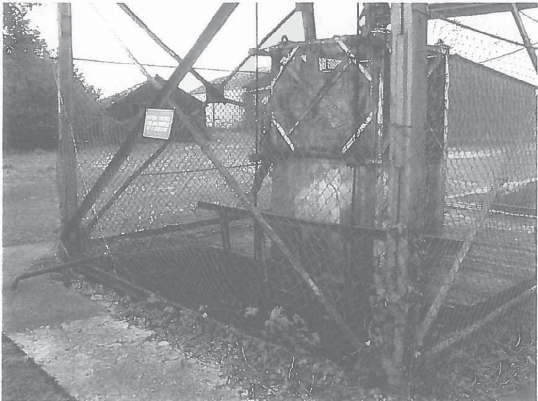
Photo n° 4 : Puits de « la Prairie », vue de l'orifice (Vue prise le 25 avril 2003)
