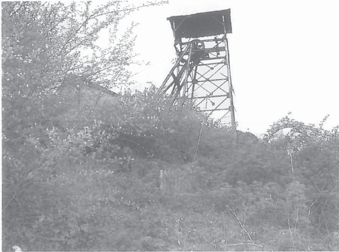
Photo n° 7 : Puits « du Milieu », vue en contrebas du chevalement (Vue prise le 25 avril 2003)
