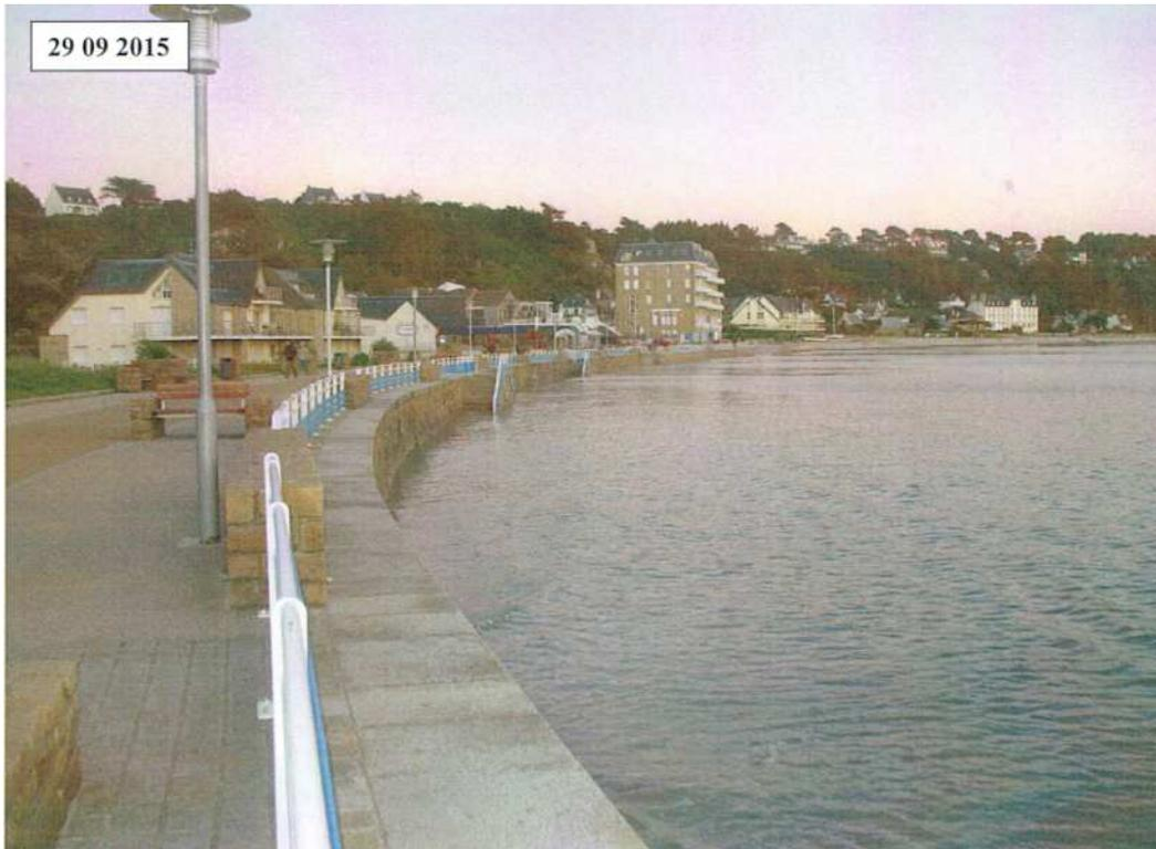
La seconde partie de la digue s'étend de la venelle C'hra Rouz jusqu'à la pointe de Bihit, soit un linéaire de 500 m environ. Dans le cadre d'une première tranche de travaux (hiver 2017/2018), une partie de la digue a été consolidée et doit recevoir un mur chasse mer.
