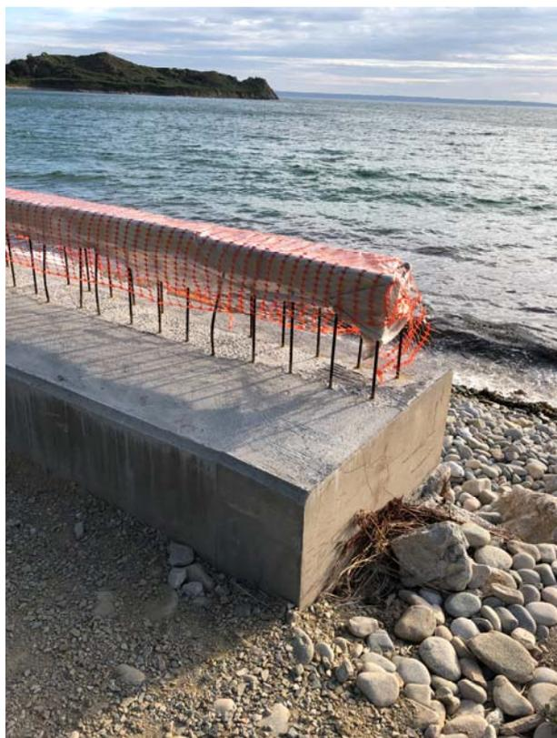
jonction entre mur consolidé et mur reconstruit La liaison se fait comment car pas d'acier en attente?
