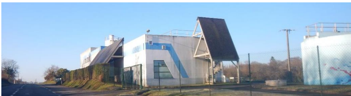
Photo 7 : Station de pompage de Kerano le long de la RD 787 à 5,5 km au nord-est du périmètre immédiat
