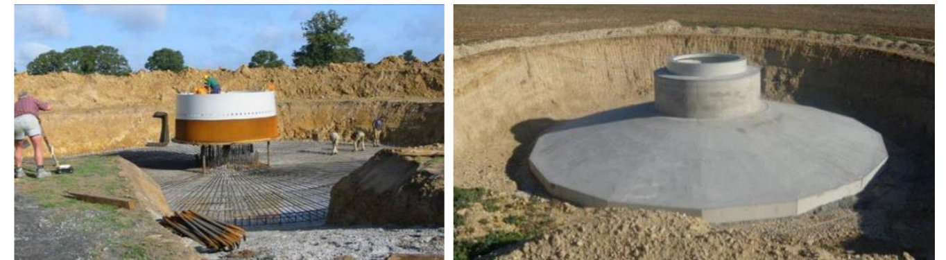
Photo 1 : Ferrailage et coulage d'une fondation
