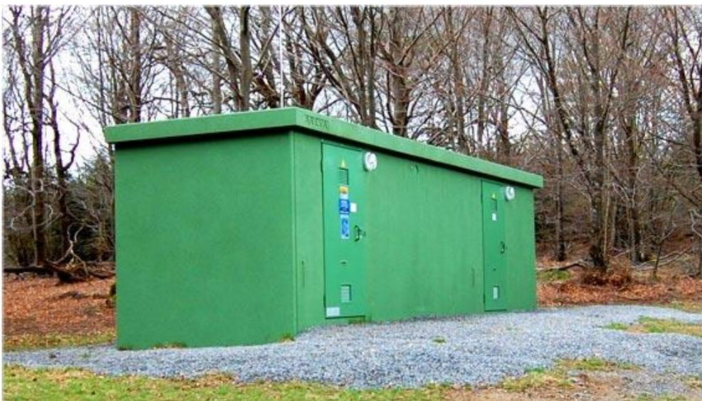
*Photo 1 : Un exemple de poste de livraison électrique*
