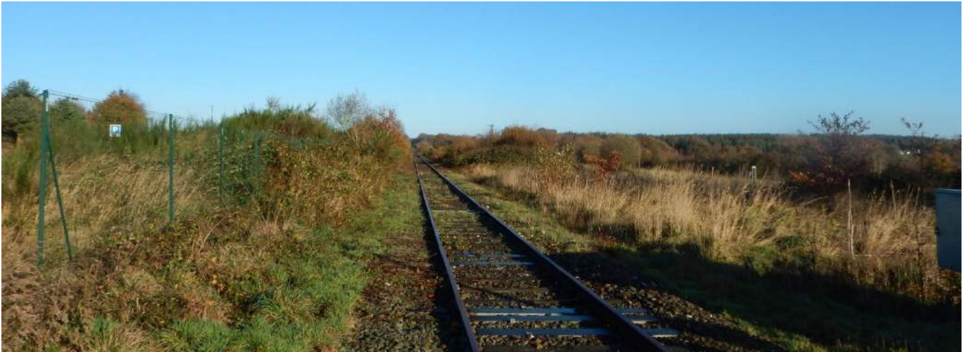
Photo 74 : Voie ferrée en direction de Saint-Brieuc
