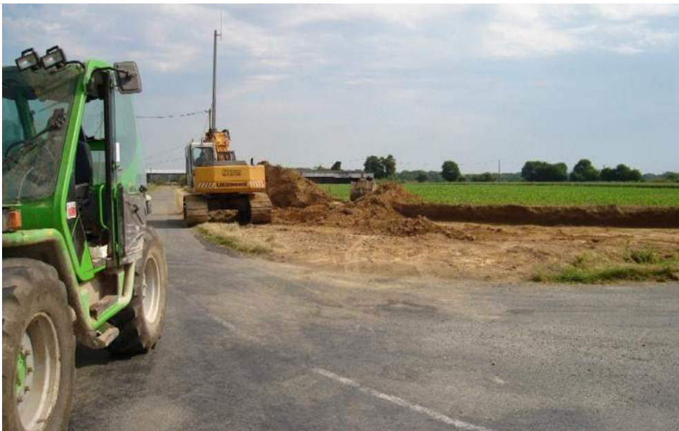
Photo 116 : Les travaux de rectification d'un virage
