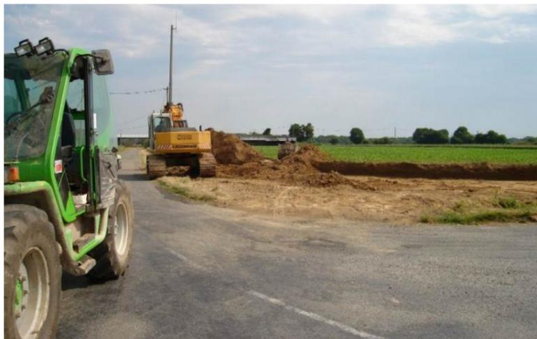
Photo 175 : les travaux de rectification d'un virage
