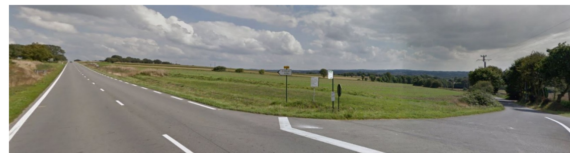
Photo 102 – RD790 – La section ouverte en direction du périmètre immédiat
