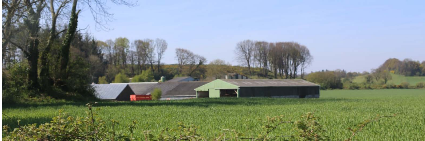
Photo 31 : bâtiments agricoles de Queniquern
