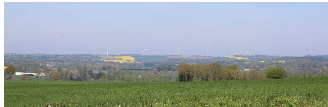
Photo 34 : parc éolien du Haut Corlay
