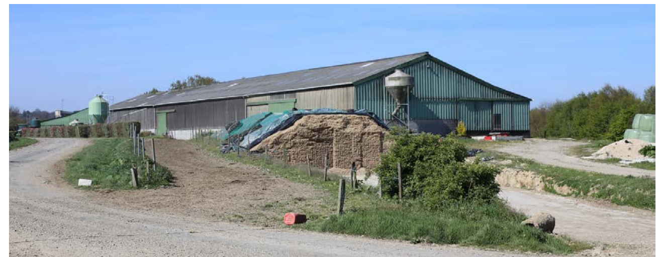
Bâtiment d'élevage à Guerglas
