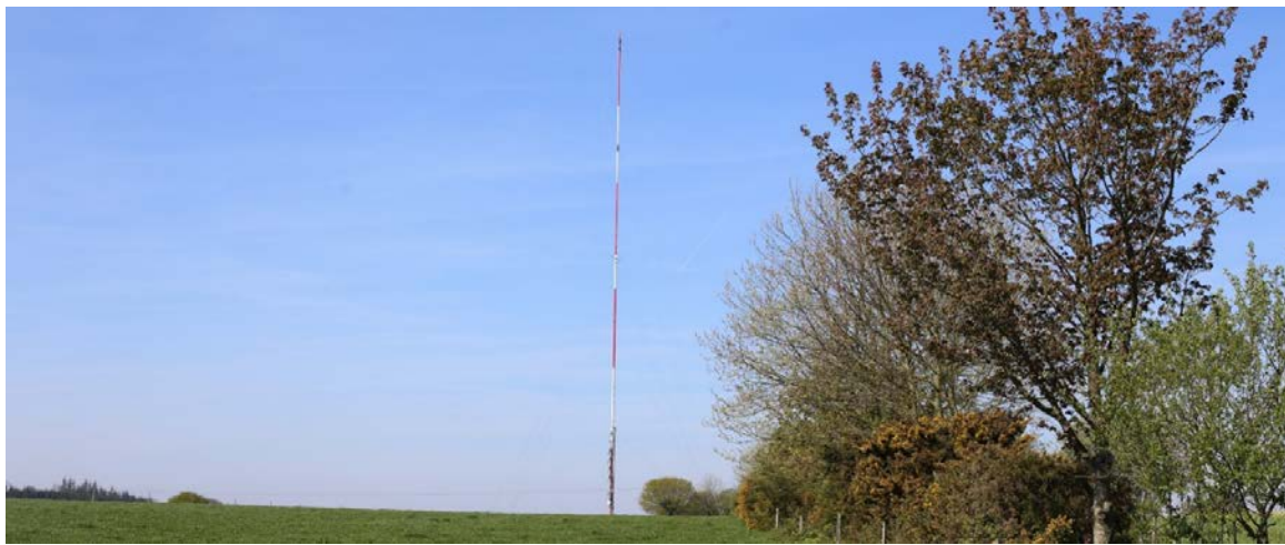
Le mât de mesure de vent installé sur le site
