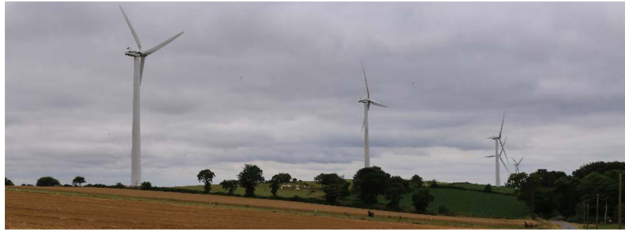
Parc éolien du Haut Corlay
