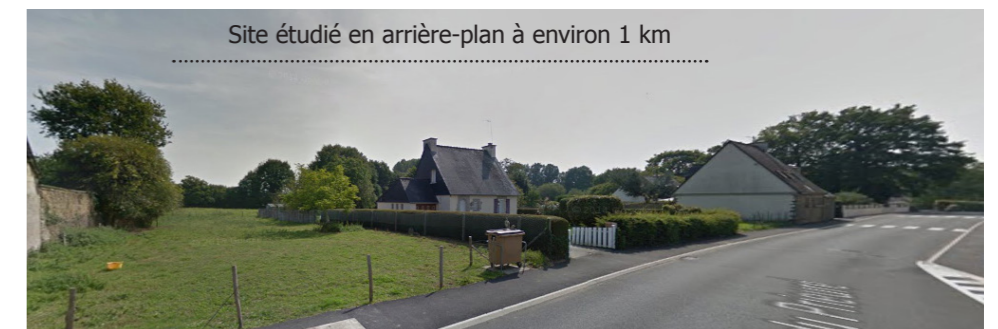
50. Vue vers le site étudié depuis la RD14 à la sortie sud-ouest de Plumieux (rue du Prieuré, source : google streetview)
