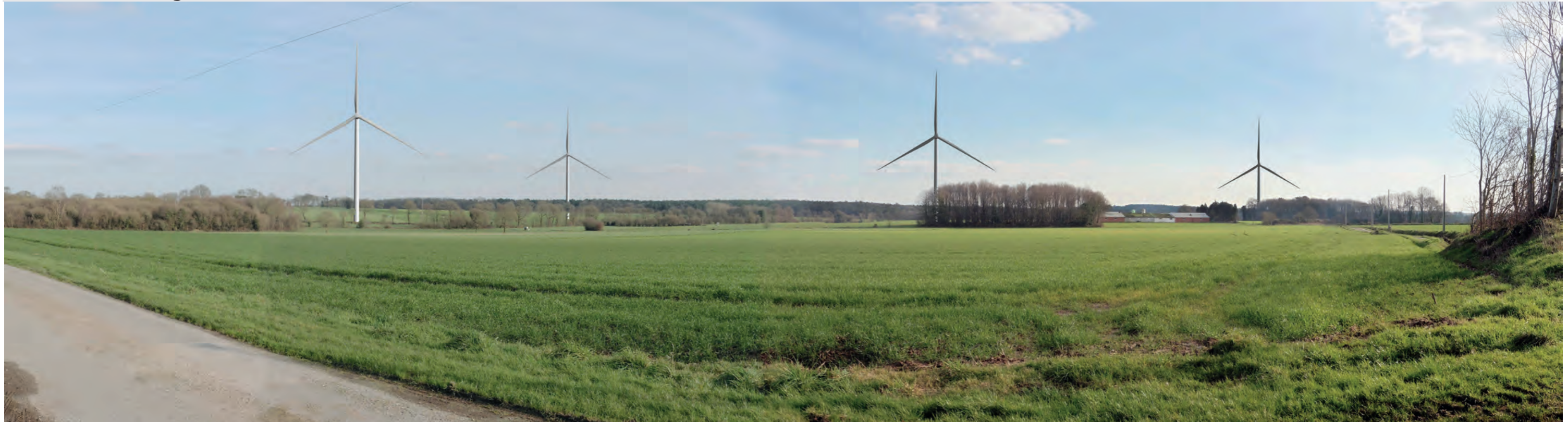
Photomontage 1 - Modèle Siemens SWT3.3-130 : rotor de 130 mètres et mât de 85 mètres soit une hauteur totale de 150 mètres
