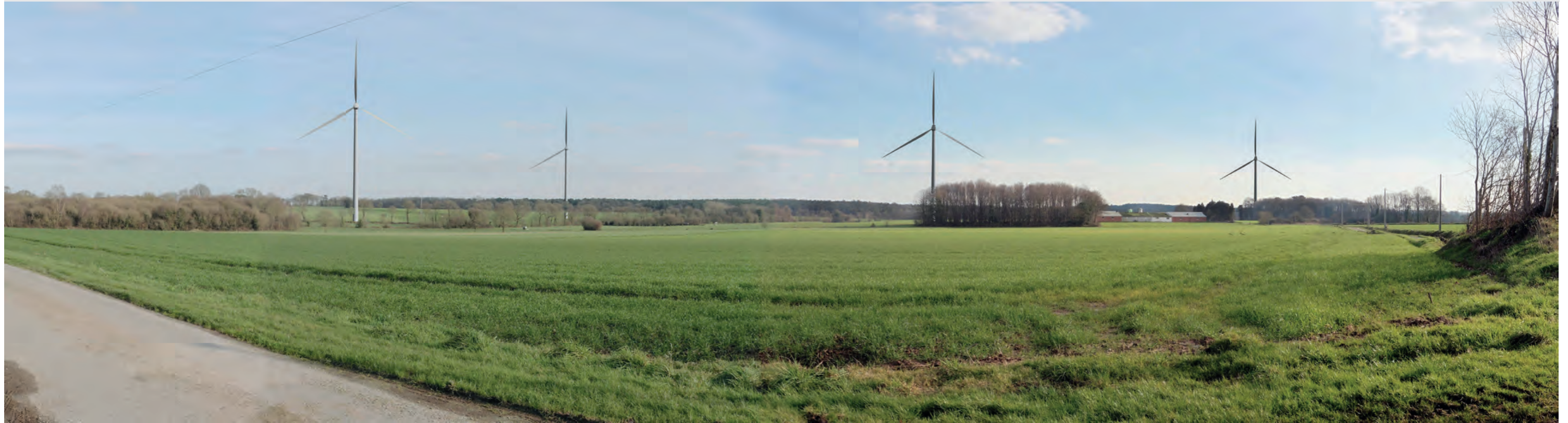
Photomontage 1 - Modèle Siemens SWT3.2-113 : rotor de 113 mètres et mât de 92,5 mètres soit une hauteur totale de 149 mètres
