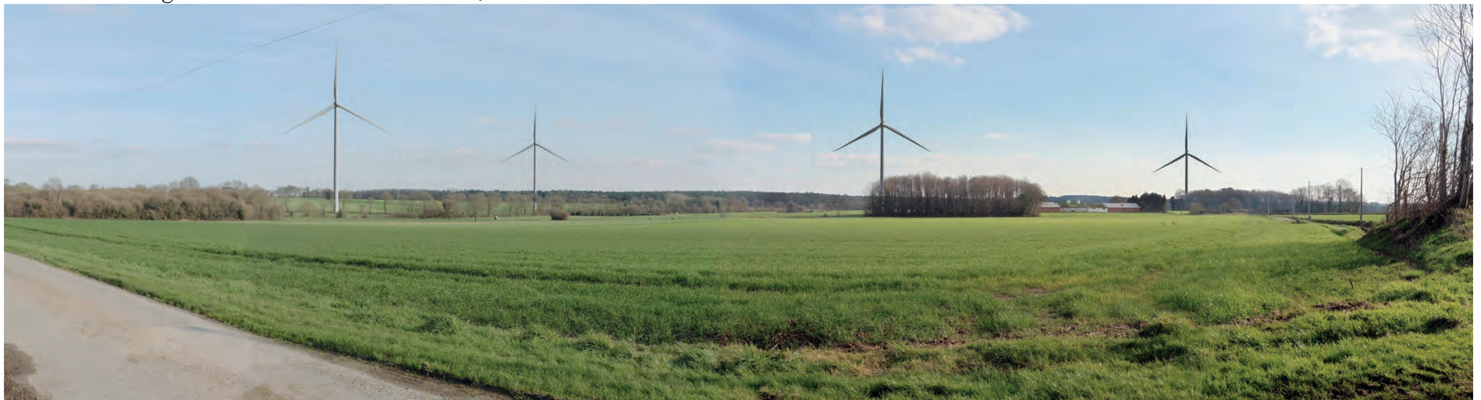
Photomontage 1 - Modèle vestas V117-3.3 : rotor de 117 mètres et mât de 91,5 mètres soit une hauteur totale de 150 mètres
