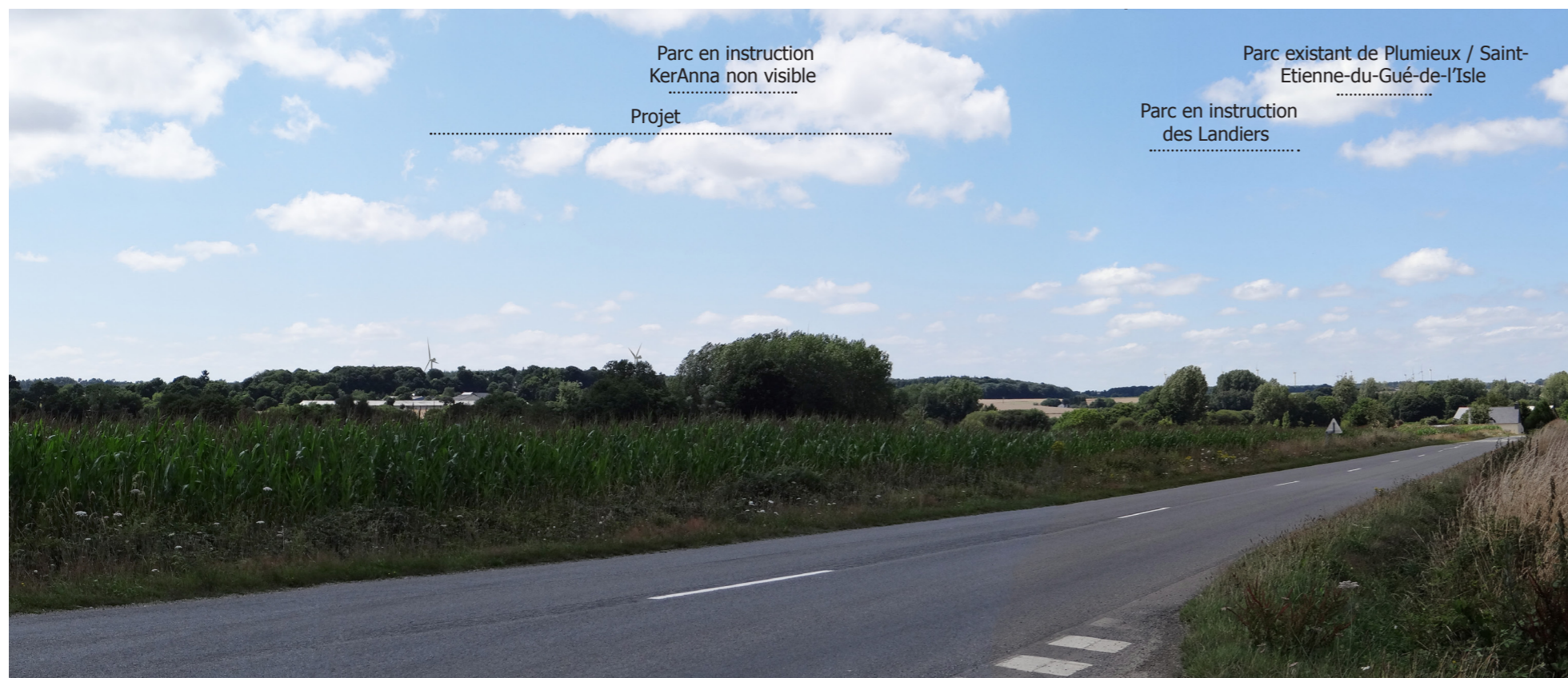
Photomontage 28 depuis la RD973 à l'Est du projet - Exemple de vue depuis l'Est (à environ 3 km du projet)
