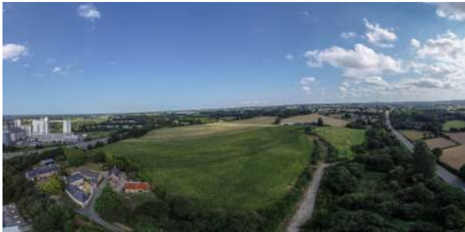
Vue aérienne du terrain existant depuis le Nord-Ouest (SOHO 2018)
