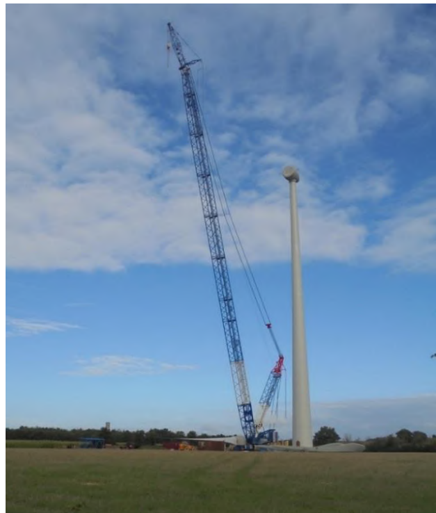
Figure 174 : Grande grue sur un chantier éolien (Source : Photos TP)
