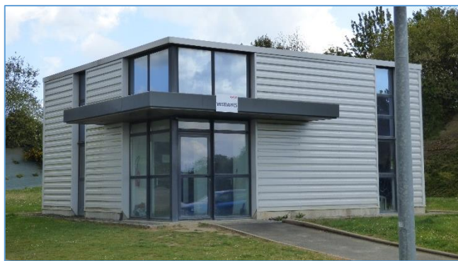
Fig. 32 : Vue n°3 : Vestiaire, sanitaires et réfectoire
