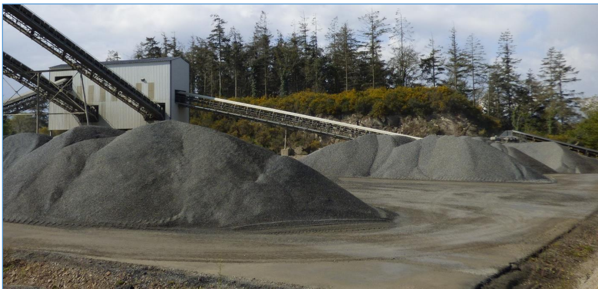
Fig. 61 : Vue sur l'aire de stockage enrobée
