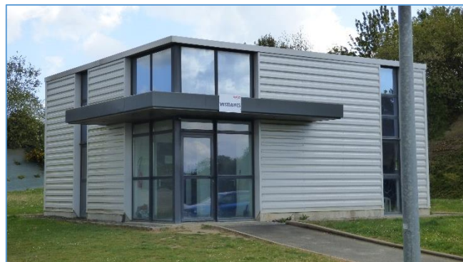
Fig. 13 : Vue n°3 : Vestiaire, sanitaires et réfectoire
