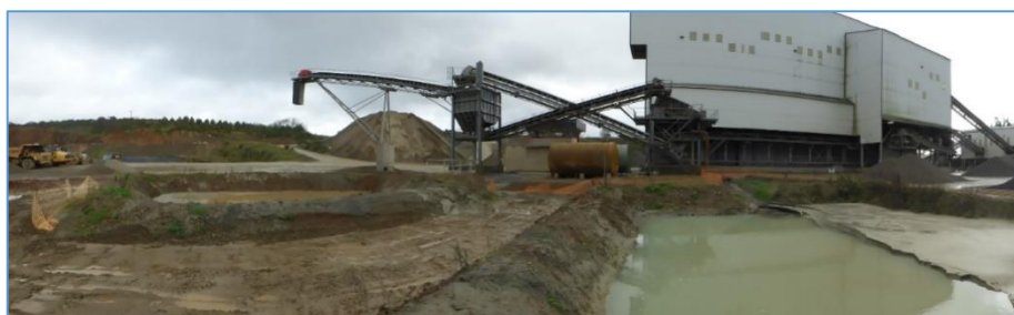
Fig. 47 : Vues sur les bassins de décantation des eaux de lavage
