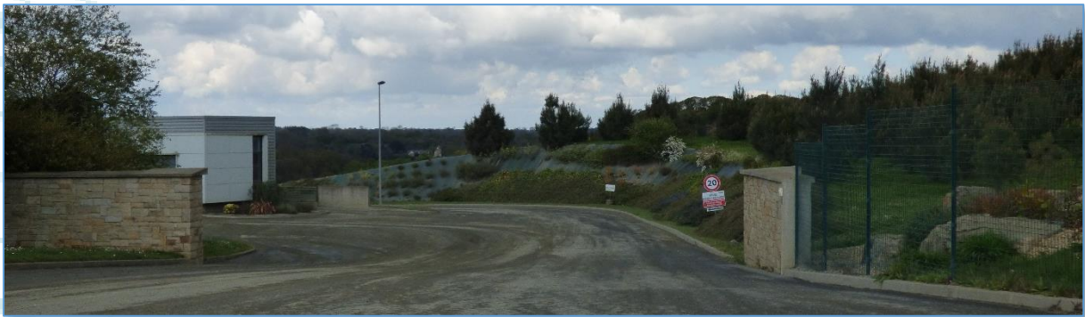
Fig. 2 : Vue sur l'accès au site
