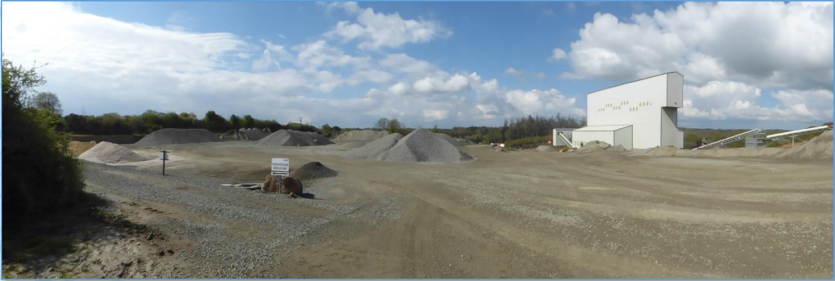
Fig. 14 : Vue n°4 : Installations de traitement secondaires et tertiaires, aire de stockage
