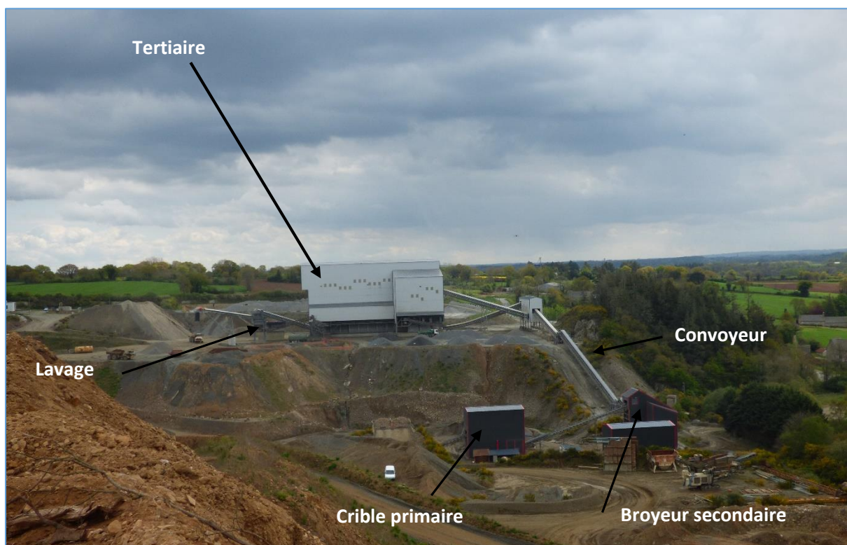
Fig. 63 : Vue sur les installations de traitement
