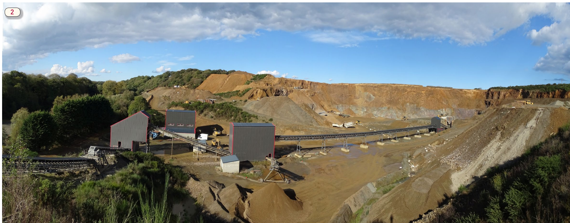
Vue générale sur la fosse et la plate-forme inférieure.
