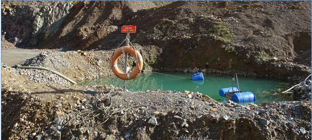
Fig. 9 : Vue D : Bassin d'eaux claires
