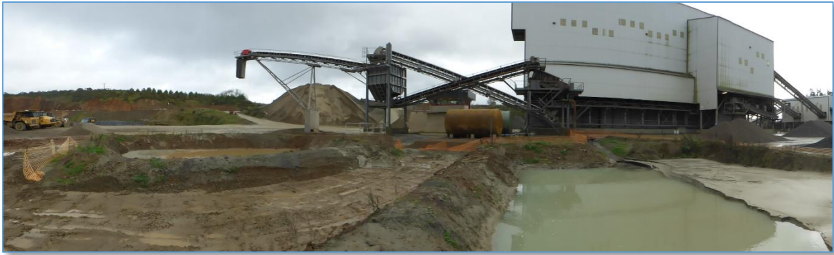
Fig. 6 : Vue A : Bassins de décantation des eaux de lavage
