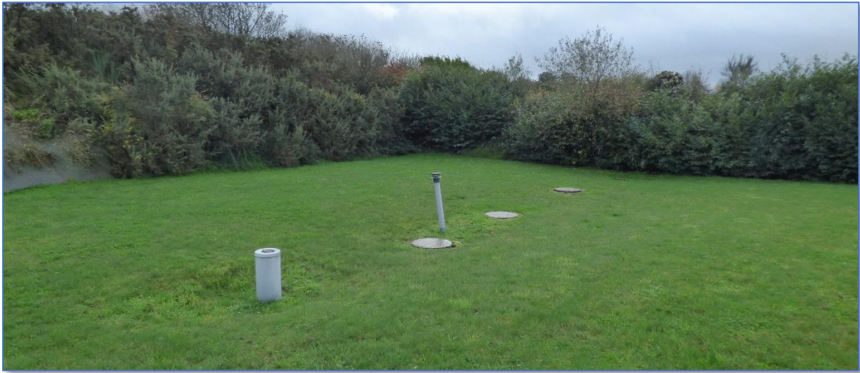
Fig. 37 : Dispositif d'assainissement autonome
