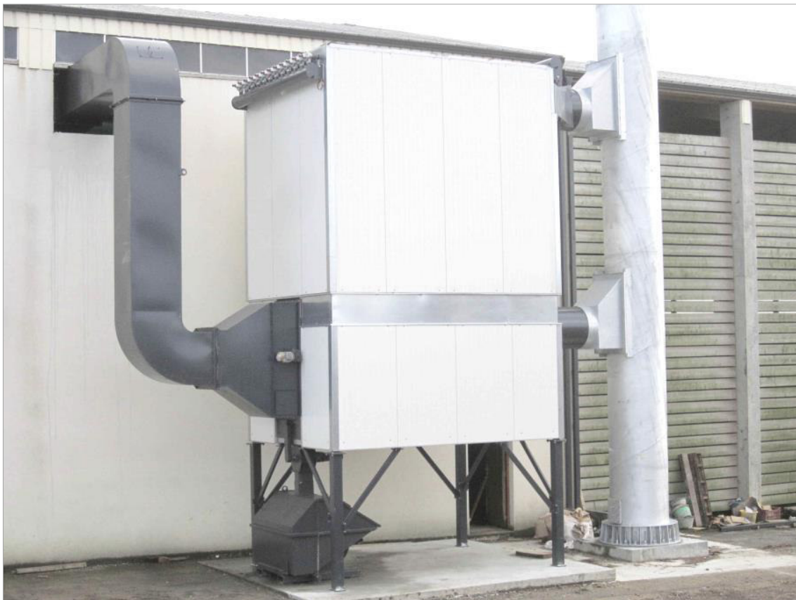
Figure 4 : Filtre pour dépoussiérage des fumées
