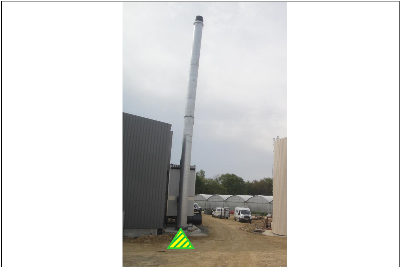
Photo n°2 : prises de terre
