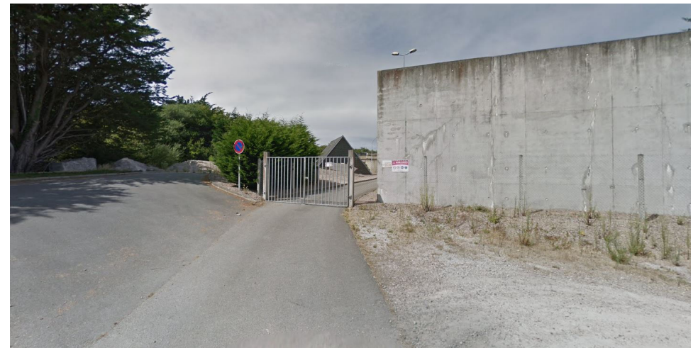
entrée de la zone d'épuration
