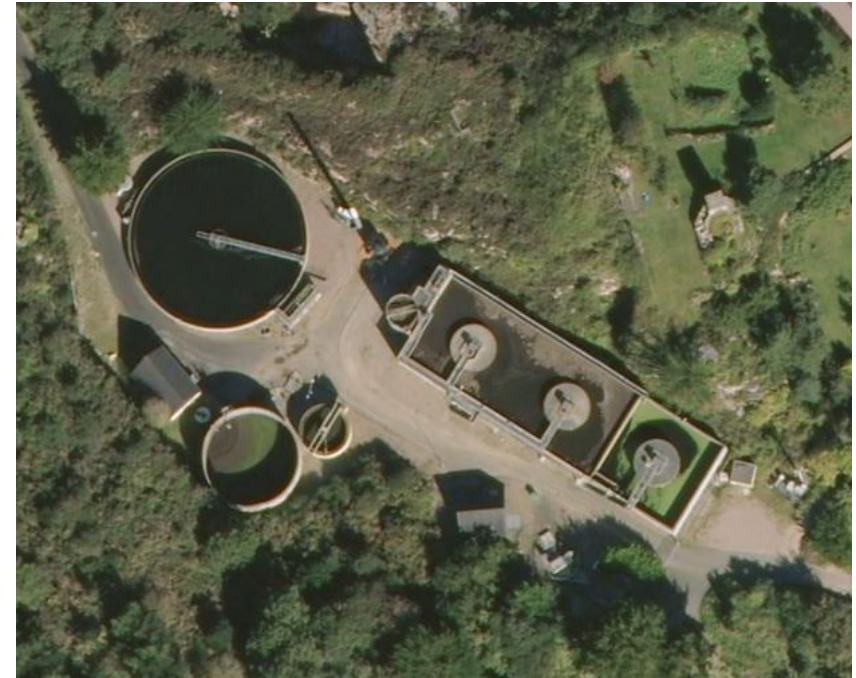
vue aérienne de la partie sud de la station d'épuration
