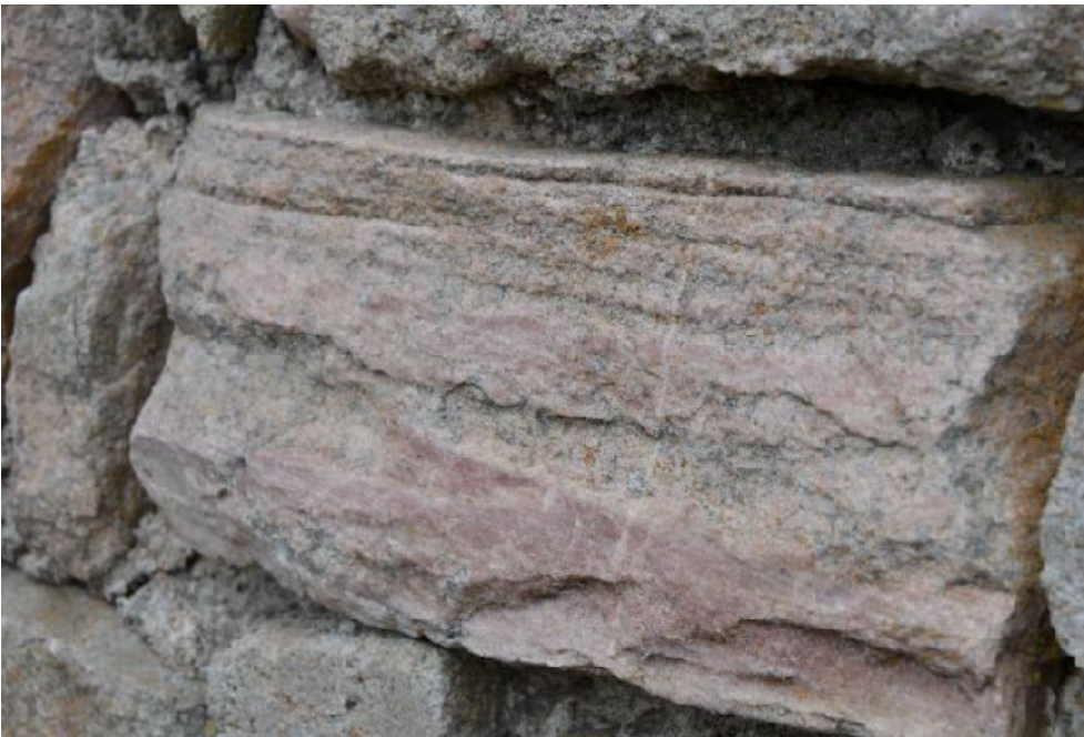
zoom sur un bloc de grès d'Erquy d'une maison de la commune
