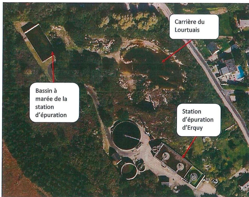
Figure 1 Situation de la station d'épuration d'Erquy & de la carrière du Lourtuais
