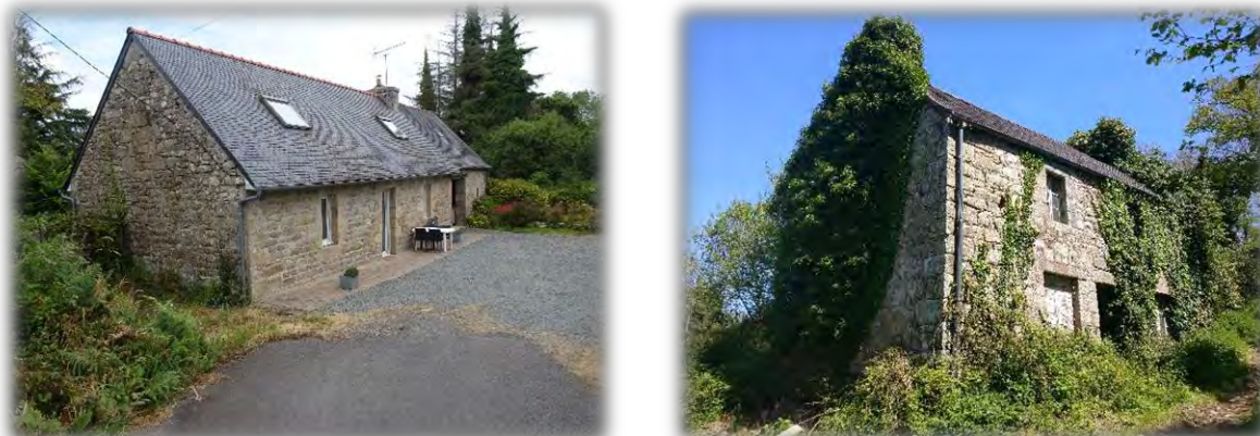
Photo 4: Maison rénovée et maison à l'abandon sur le site
