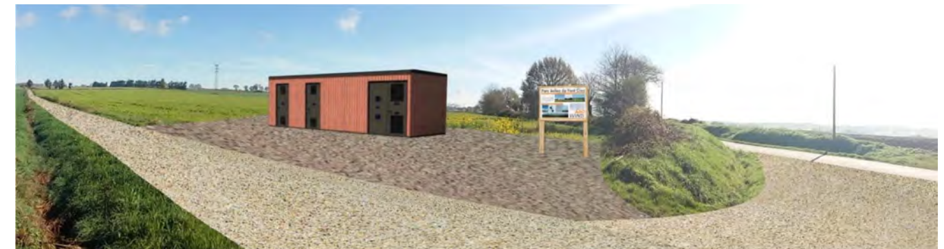
Insertion du poste de livraison (Source : Abo wind)
