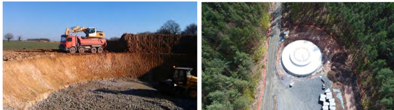
Illustration 109: Travaux pour une fondation (Source : ABO Wind)
