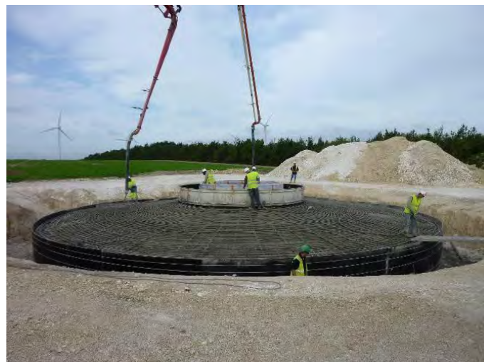
Illustration 118: Construction d'une fondation
