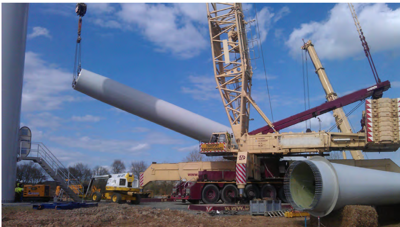
Illustration 119: Grue de levage sur une plateforme
