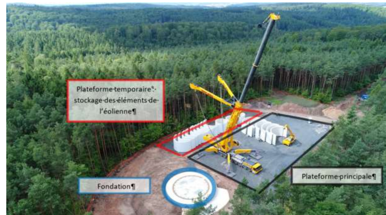
Figure 31 Illustration d'un chantier éolien (source ABO Wind)
