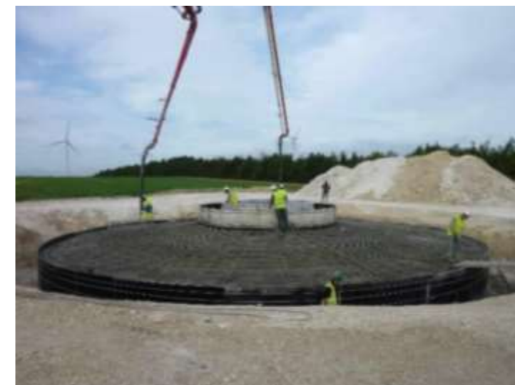
Figure 33 Construction d'une fondation (source ABO Wind)
