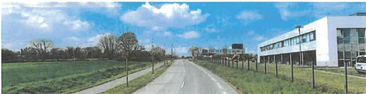
Rue Pierre & Marie Curie : Tourelle 1 à droite. Terrains à acquérir pour l'extension de la zone à gauche de la rue.
