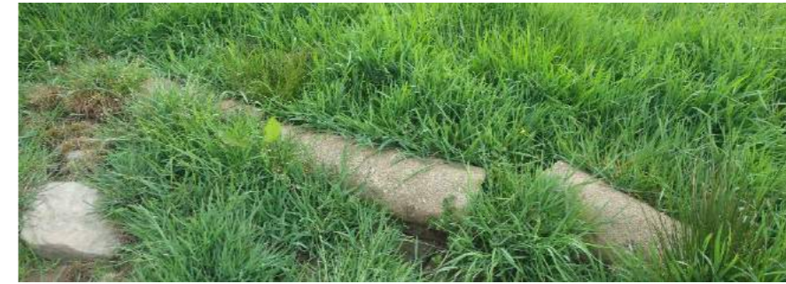
Photographie 10 : Restes de canalisations bétons (source : ENCIS Environnement)
