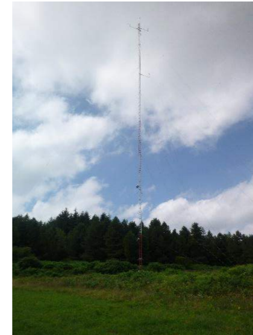
Photographie 1 : Mât de mesure installé sur le site (Source : ENCIS Environnement)
