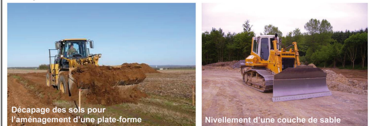
Photographie 30 : Exemples d'engins de travaux de VRD
