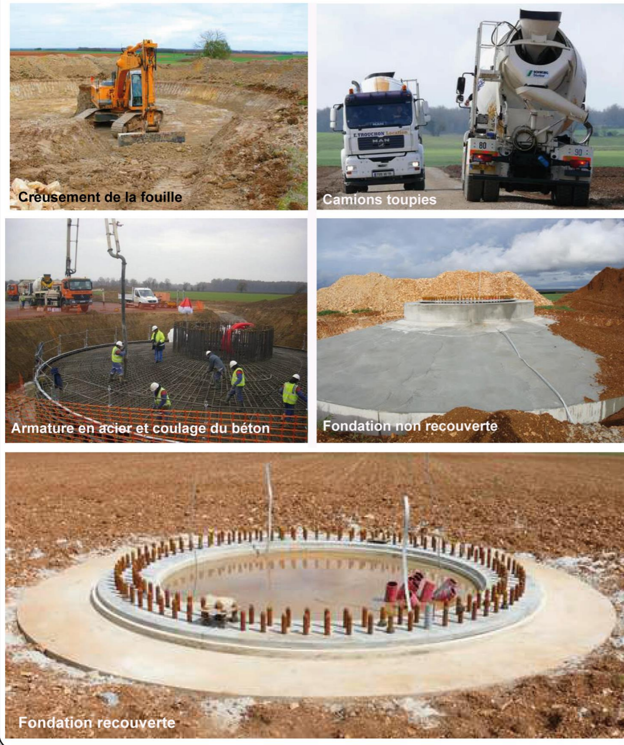
Photographie 31 : Etapes de réalisation d'une fondation d'éolienne
