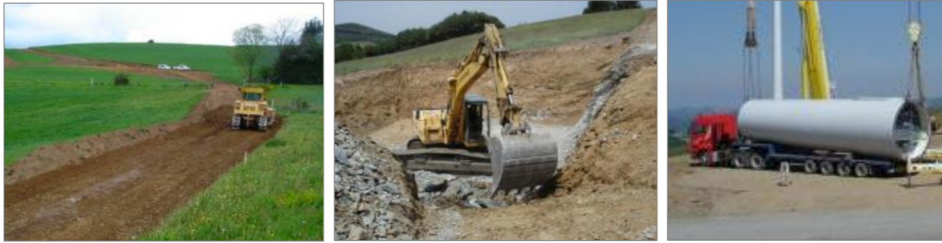
Photographie 35 : Illustration d'un chantier éolien
