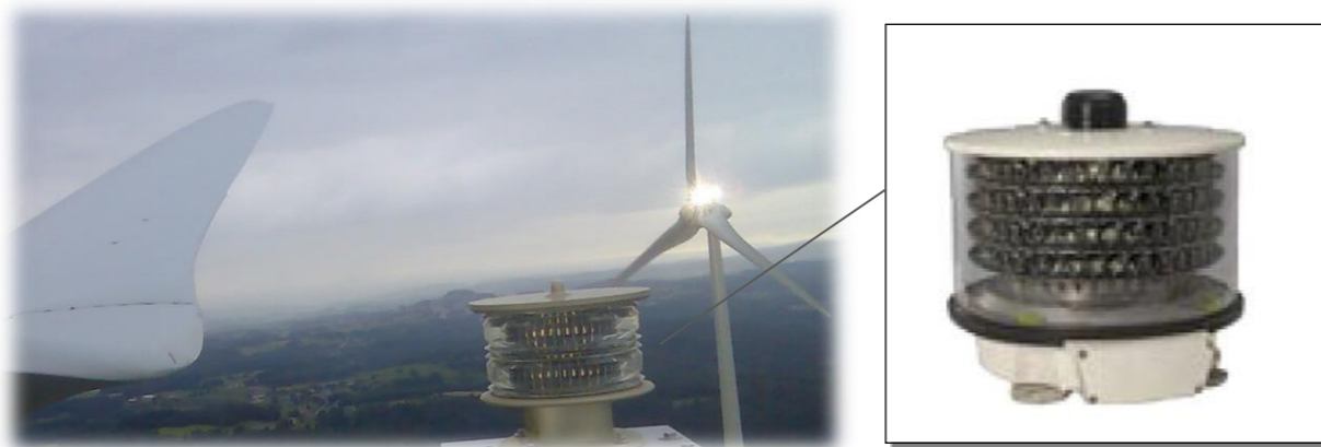
Figure 47 : Balisage d'une éolienne
