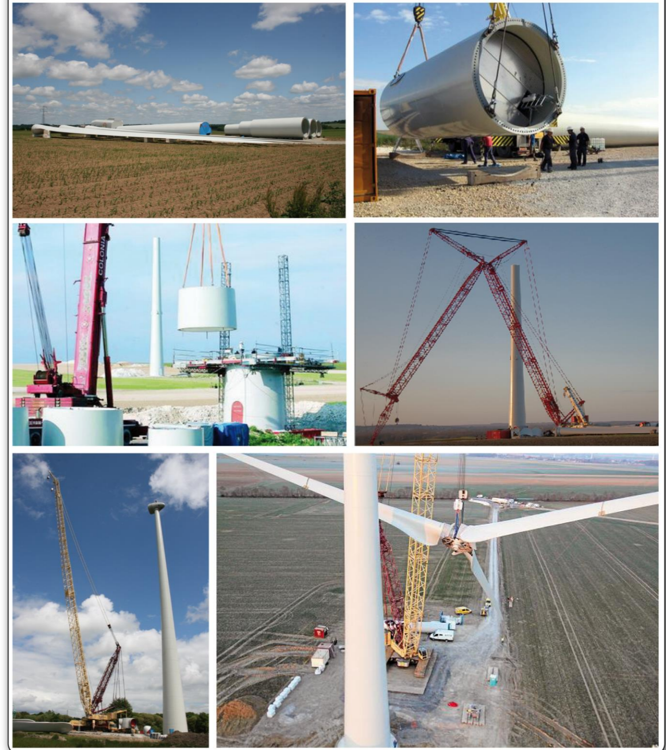
Montage d'une éolienne
