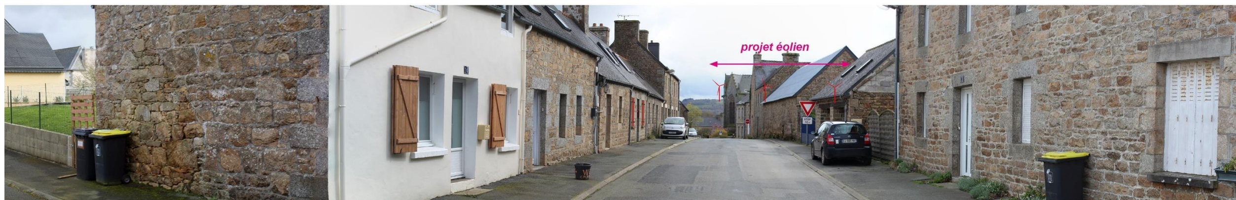
Figure 66 : Covisibilité entre l'église et l'éolienne E3 s'élevant dans l'axe de la rue Saint-Eloi (esquisse)
