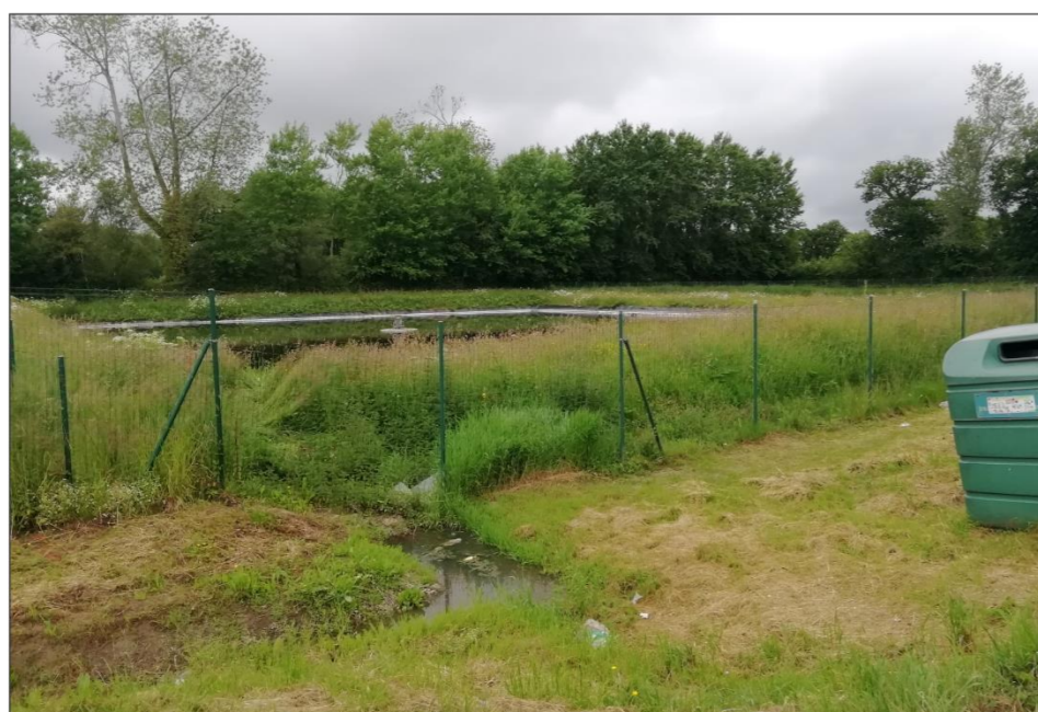
Photographie 8 : Vue vers la lagune n°1 (vers le Nord-Nord-Ouest)
