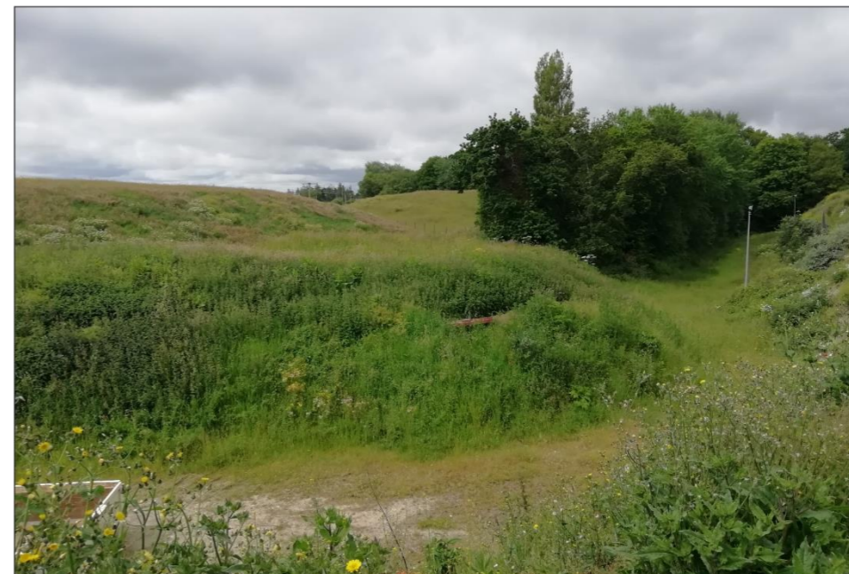
Photographie 6 : Vue depuis l'ISDI vers l'ancienne décharge réhabilitée (vers le Sud)
