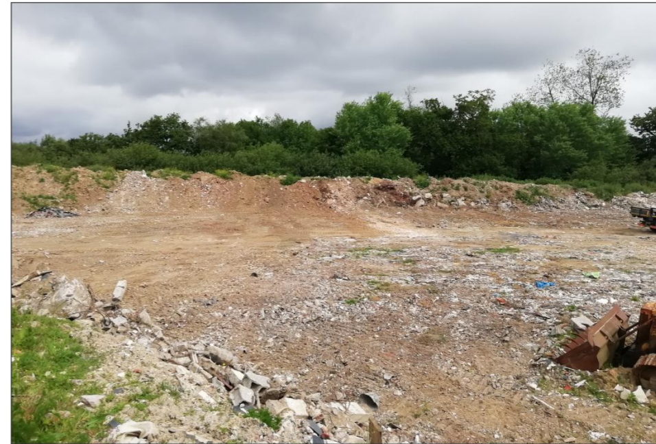
Photographie 4 : Vue depuis l'ISDI vers le Nord
