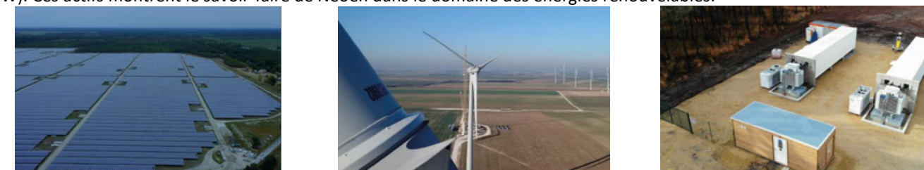
Figure 8 : De gauche à droite, Centrale Solaire de Cestas (300 MWc), Centrale Eolienne de Bussy-Lettrée (26 MW), et Azur Stockage (6MW, 6MWh) (Source : NEOEN, 2019)
