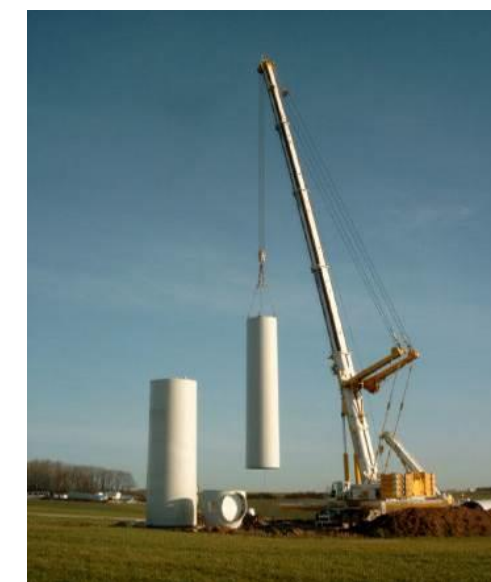
Figure 54 : Assemblage de la deuxième section de la tour
