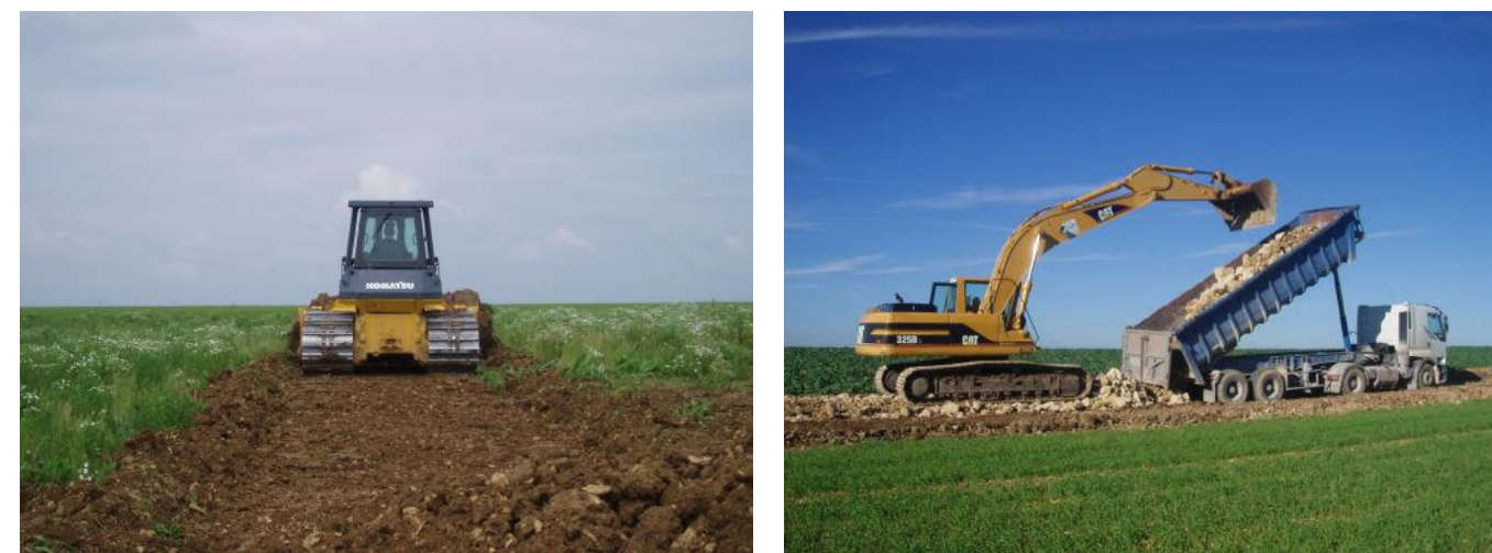
Figure 48 : Mise en forme des chemins d'accès
