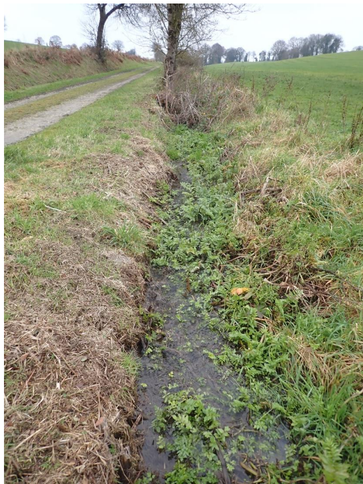
Figure 60 : Cours d'eau busé au niveau du pan coupé
