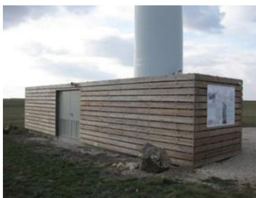
Figure 46 : Photographie d'un poste de livraison (Source : NEOEN)
