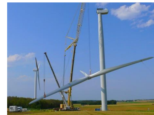
Figure 57 : Hissage du rotor complet
