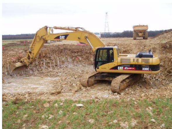
Figure 49 : Fouille de la fondation
