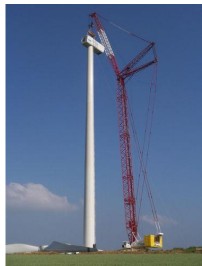
Figure 56 : Fixation de la nacelle sur la tour
