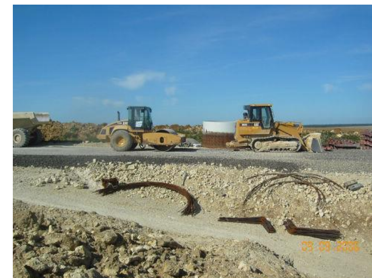
Figure 47 : Aplanissement du terrain
