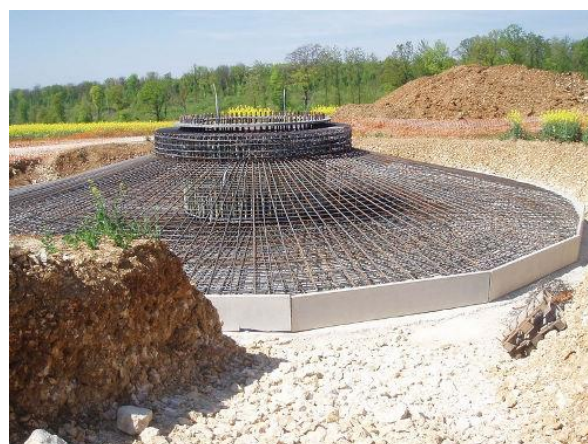
Figure 50 : Ferrailage de la fondation
