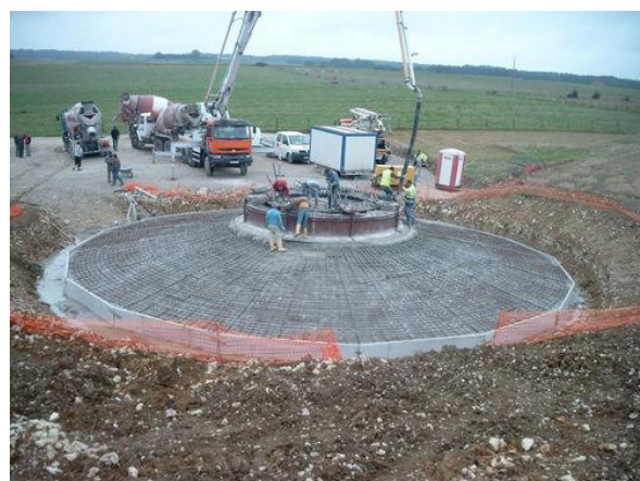
Figure 51 : Ferrailage de la fondation
