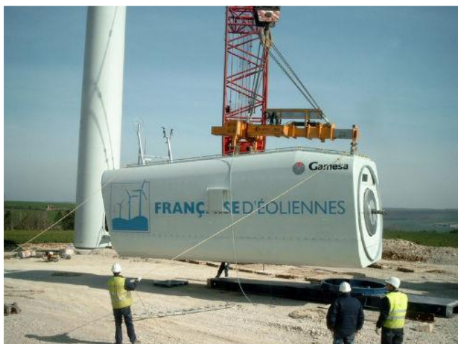
Figure 55 : Hissage de la nacelle
