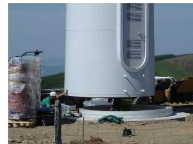
Figure 53 : Assemblage de la première section de la tour
