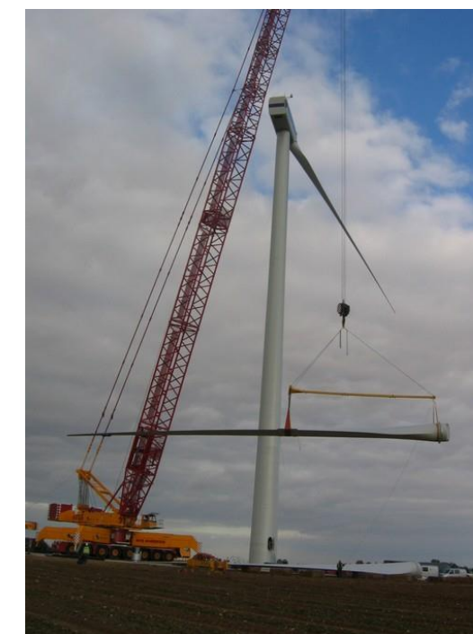
Figure 58 : Système de levage d'une pale
