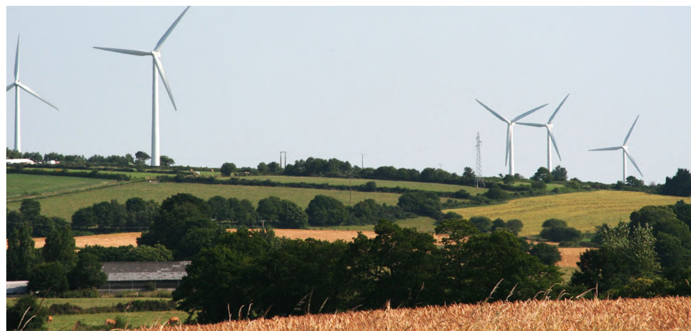
Figure 14 : Unité paysagère du massif du Mené - Un paysage caractérisé par la présence de plusieurs parcs éoliens, notamment sur le secteur de la cime de Kerchouan (ici le parc de Lanfains)
