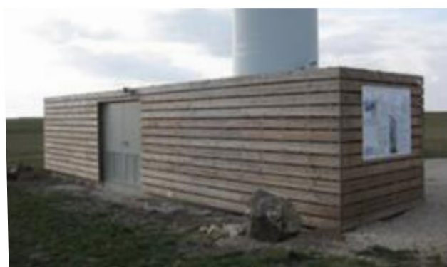
Figure 55 : Type de poste de livraison prévu au projet (Source : Neoen)
