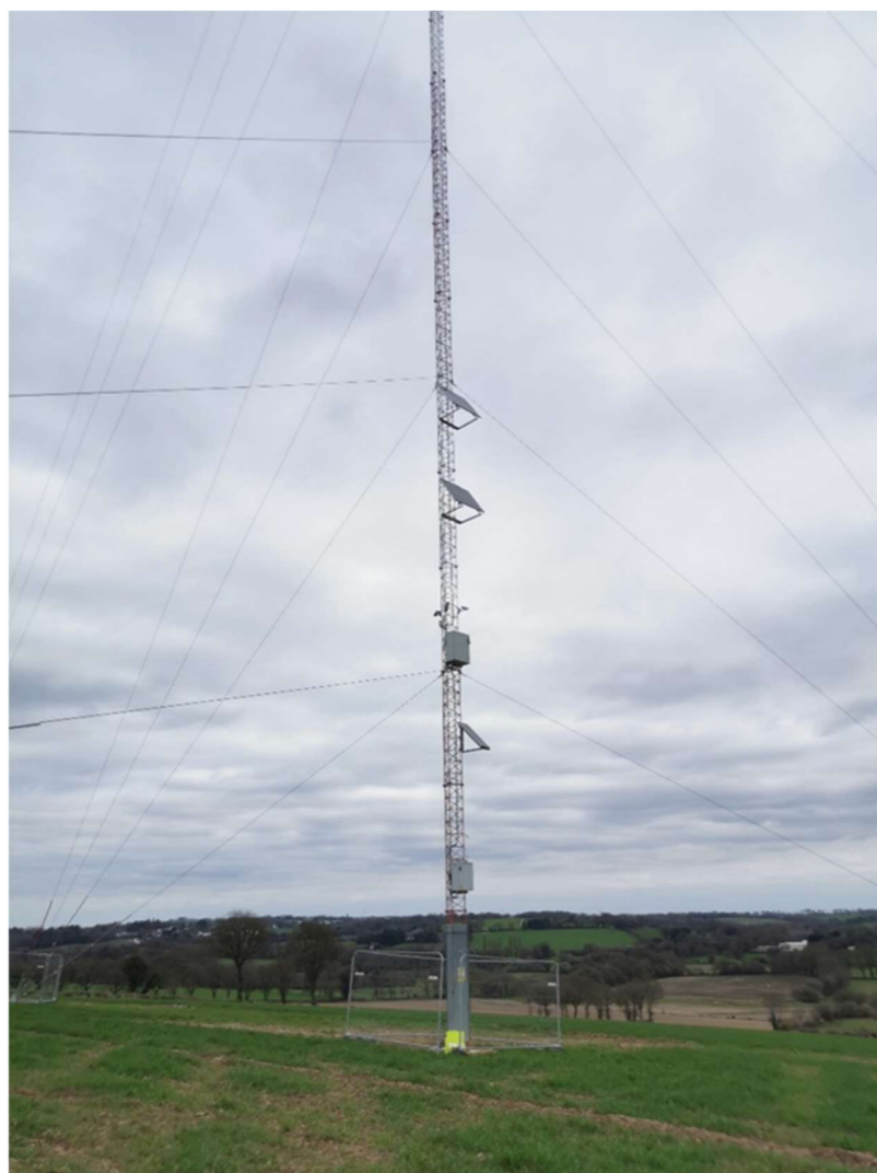
Figure 50 : Mat sur lequel l'enregistreur a été installé
