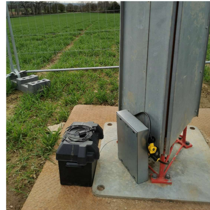
Figure 49 : Enregistreur installé au pied du mat
