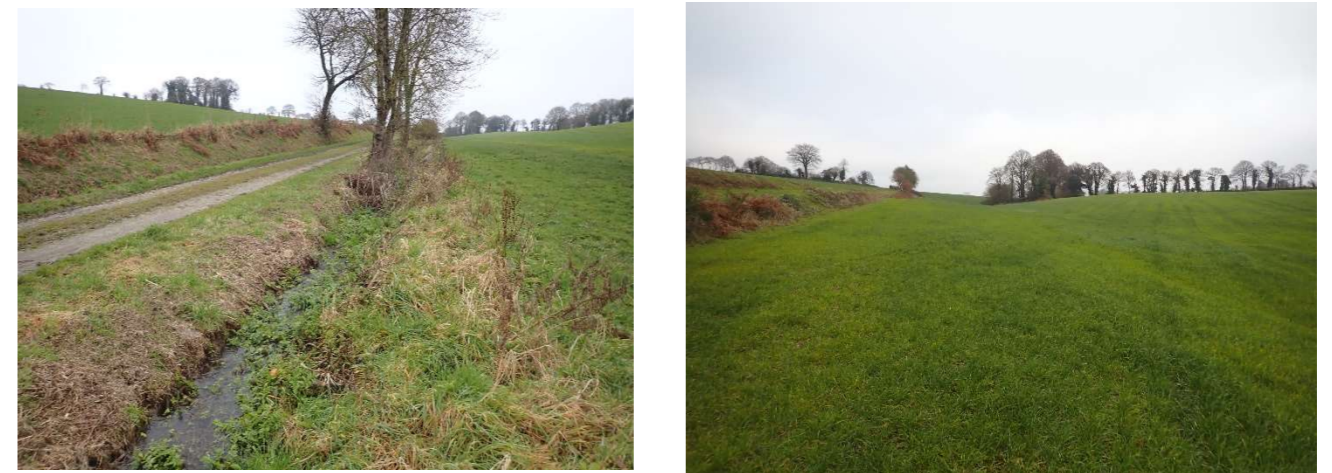
Figure 21 : A droite l'écoulement dans le fossé au bord du chemin. A gauche, le talweg juste en amont
