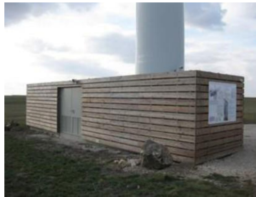
Figure 38 : Photographie d'un poste de livraison (Source : NEOEN)
