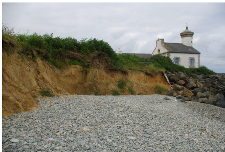
Fig. 4. Érosion au phare de Nantouar
