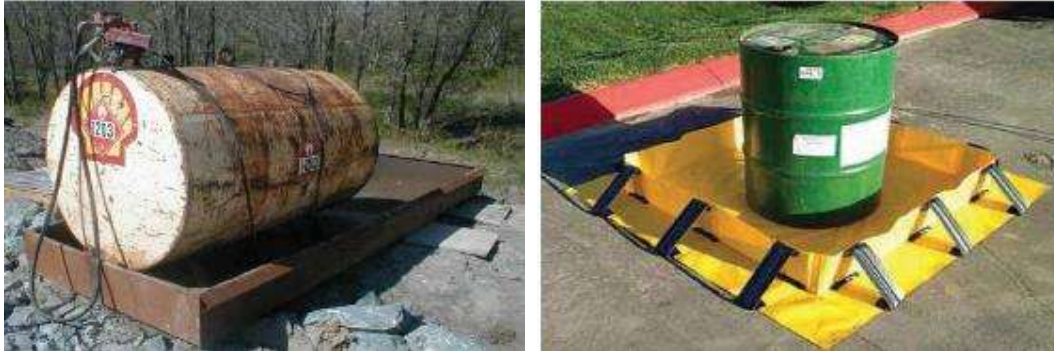
Exemple de stockage de produits dangereux sur rétention
