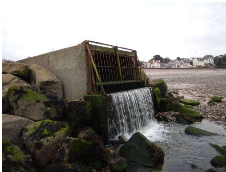
Fig. 12. Amont du Val canalisé et émissaire sur la plage du Bourg
