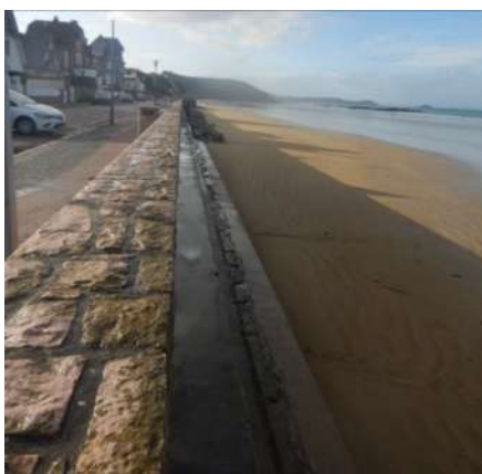
Fig. 21. Digue de Caroual
