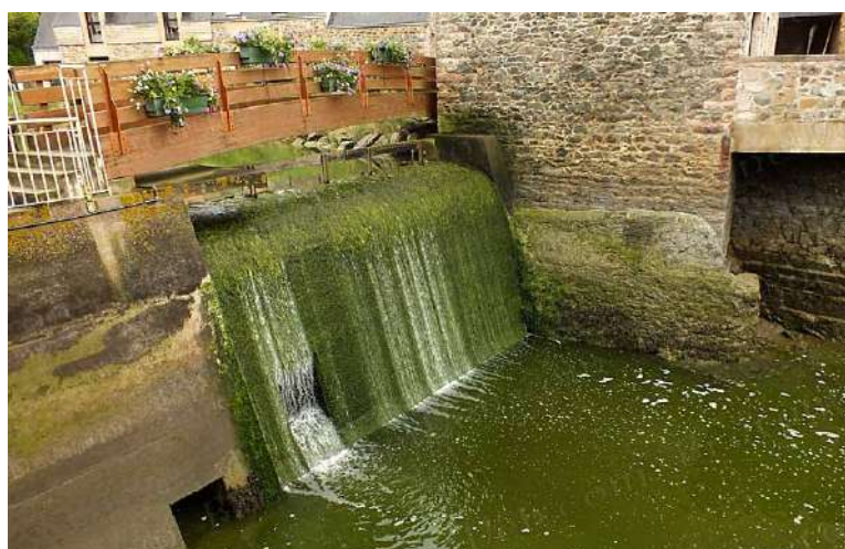
Fig. 17. Étang de Dahouët depuis la passerelle amont jusqu'au déversoir aval
