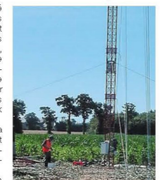
L'installation du mât, de 110 m de haut, a nécessité le travail de deux spécialistes du travail en hauteur.
