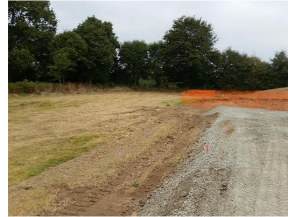
Photo 49 – Exemple de filet de chantier permettant de délimiter des emprises au sol.
