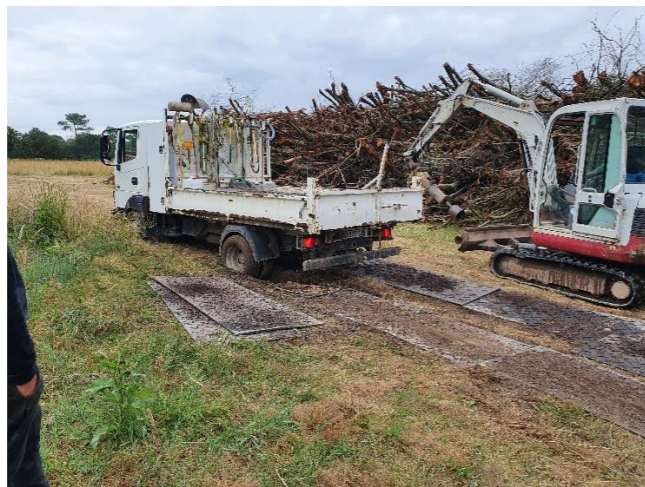
Photo 48 – Mise en place d'une piste sur plaque
