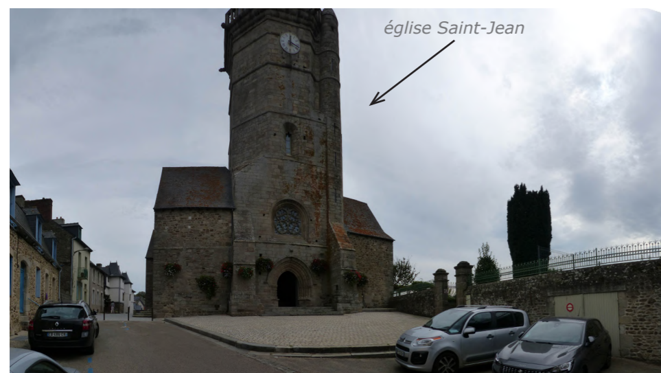
Vue panoramique sur le portail de l'église Saint-Jean à Lamballe
