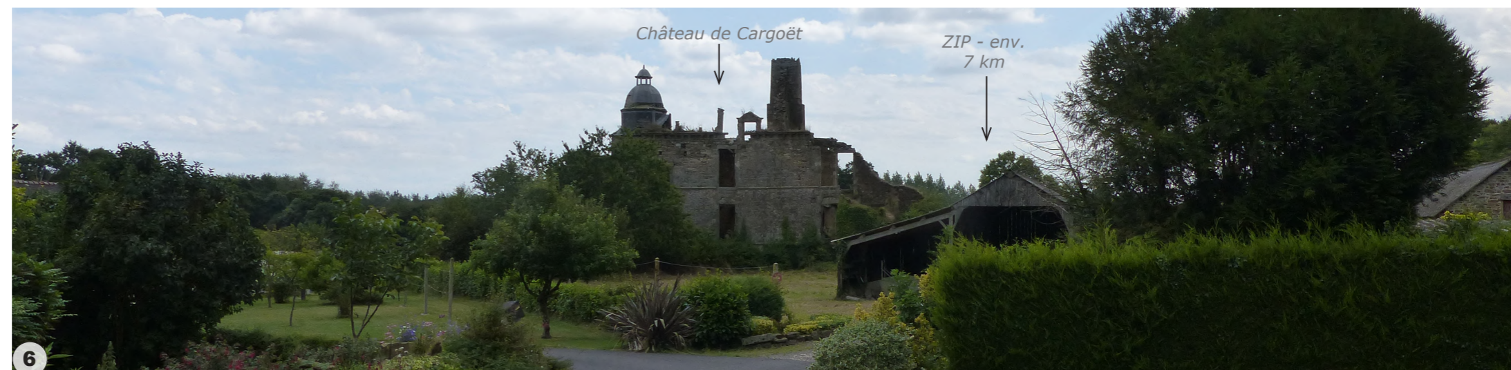
Vue panoramique sur le Château de Cargoët, à Meslin.
